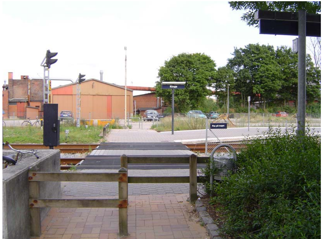
1 Overgangen set fra adgangsvej fra forplads og cykelparkering, juli 2005
