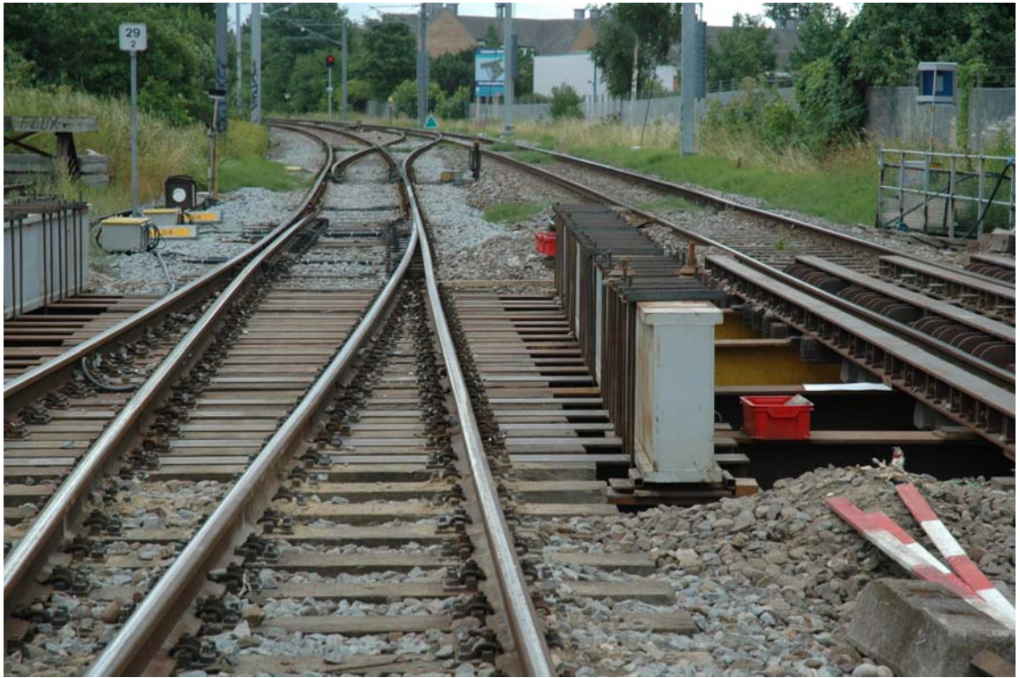
Figur 1. Kassedrageren set fra nord, det ses tydeligt, at drageren er blevet flyttet i nordenden, idet den skulle have ligget parallel med den lige gren i sporskiftet.
