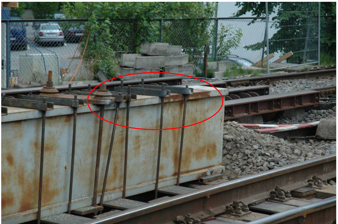
Figur 2. Kassedrageren med påkørselsmærker øverst
