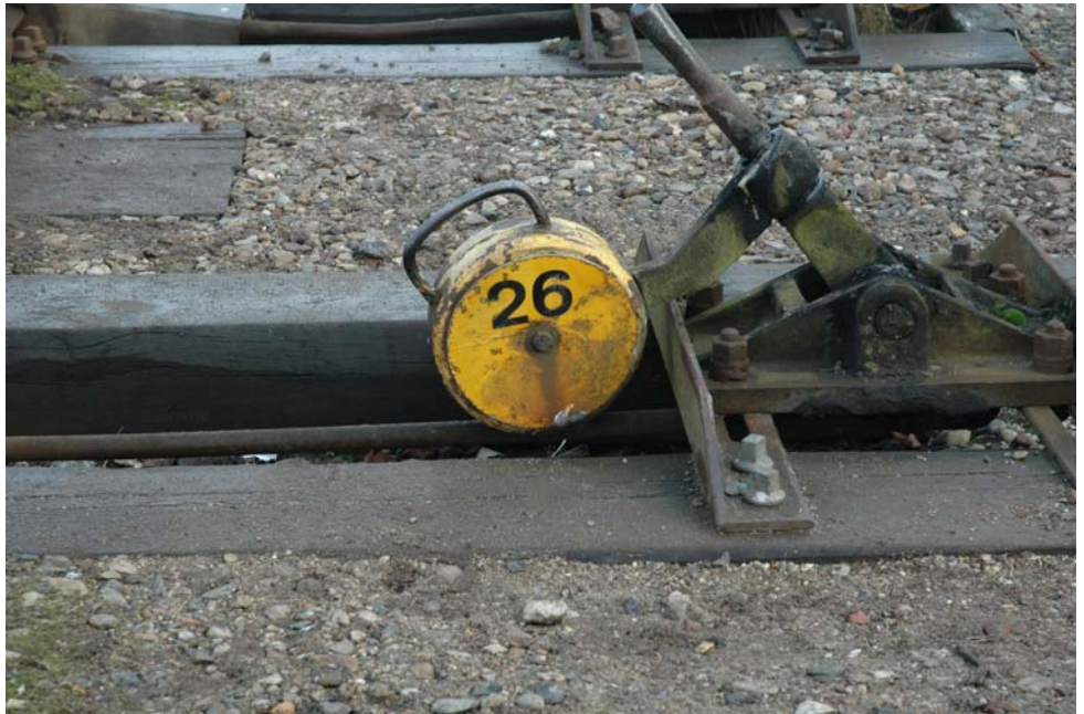
Figur 3. Kontravægten, der hviler på trækstangen til sporskiftet.
