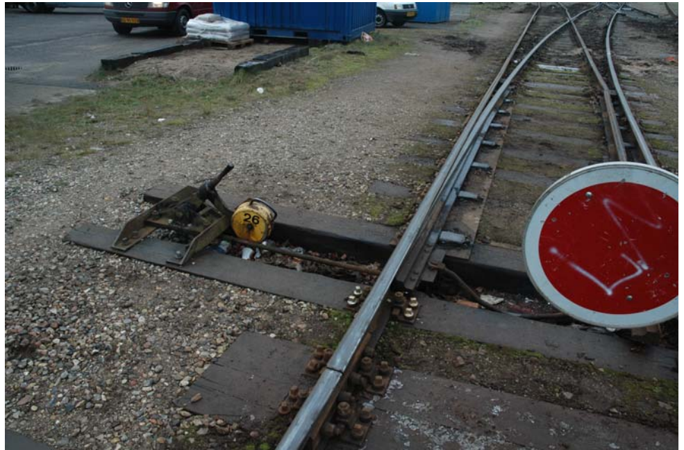
Figur 5. Tungen, som den burde ligge, når kontravægten placeredes ”korrekt”.
