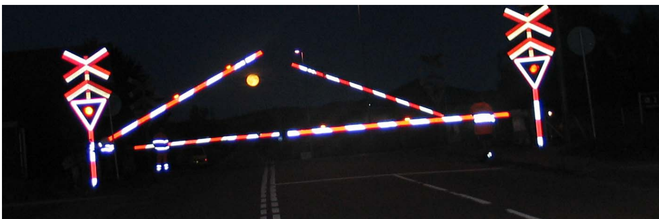
Overkørsel 491 er forsynet med helbomanlæg
