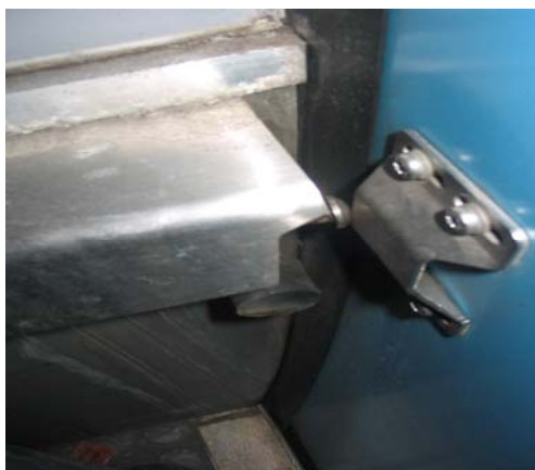
Foto 4: Dørsæt (bagerste dørblad i højre side i køreretningen) på MFA 5033
