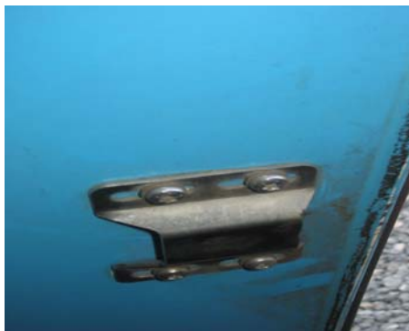
Foto 2: Sikringsbeslag på det opblæste dørblad.
