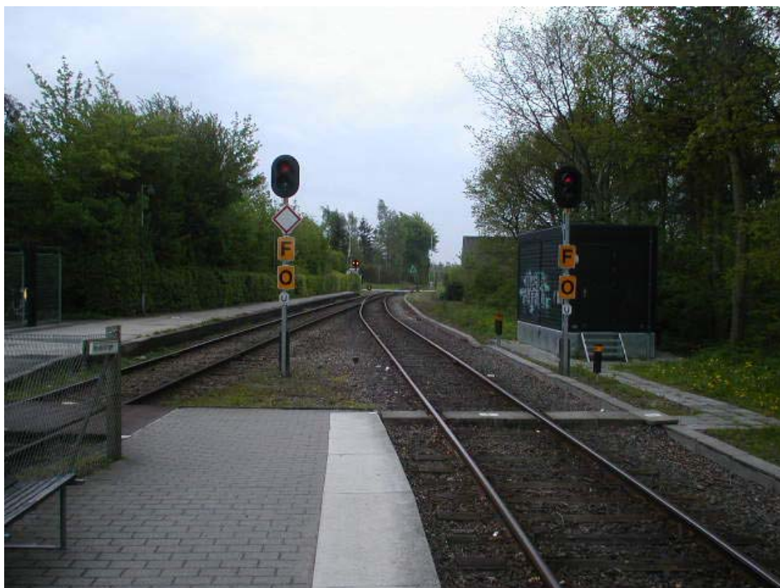
Figur 1: Kværndrups sydlige udkørsel med spor 2 til højre. Overgang til perron ved spor 1 ses til venstre i billedet.
