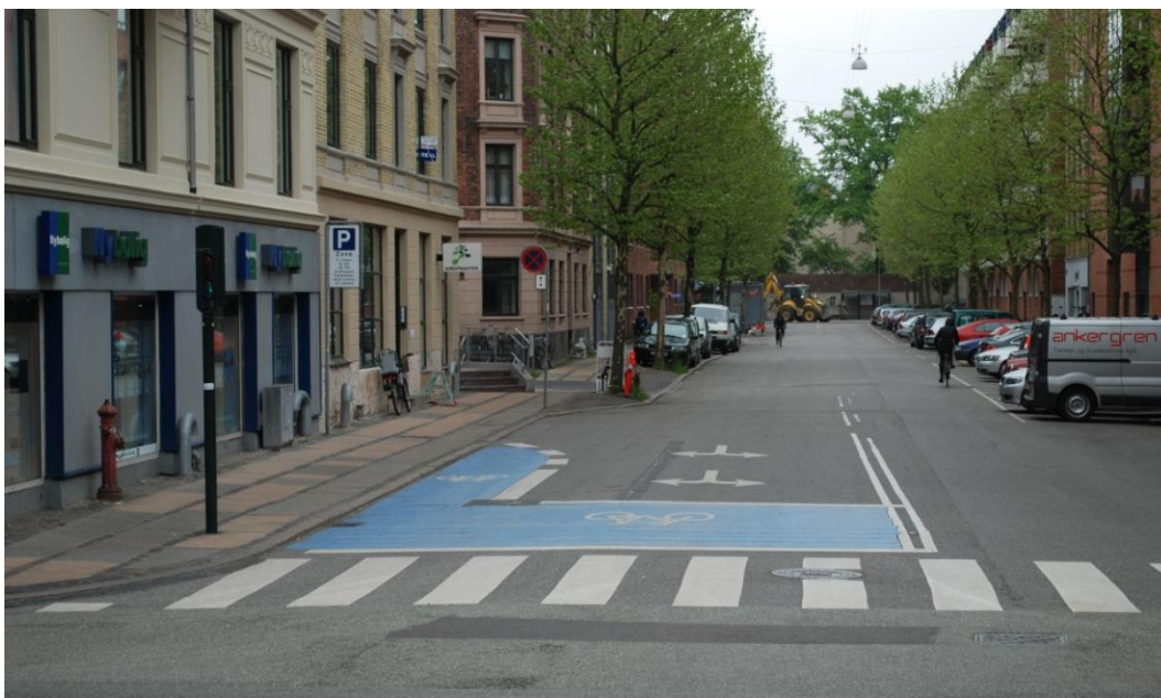
Cykelboks i tilfarten på sidevej i T-kryds (Danmark)
