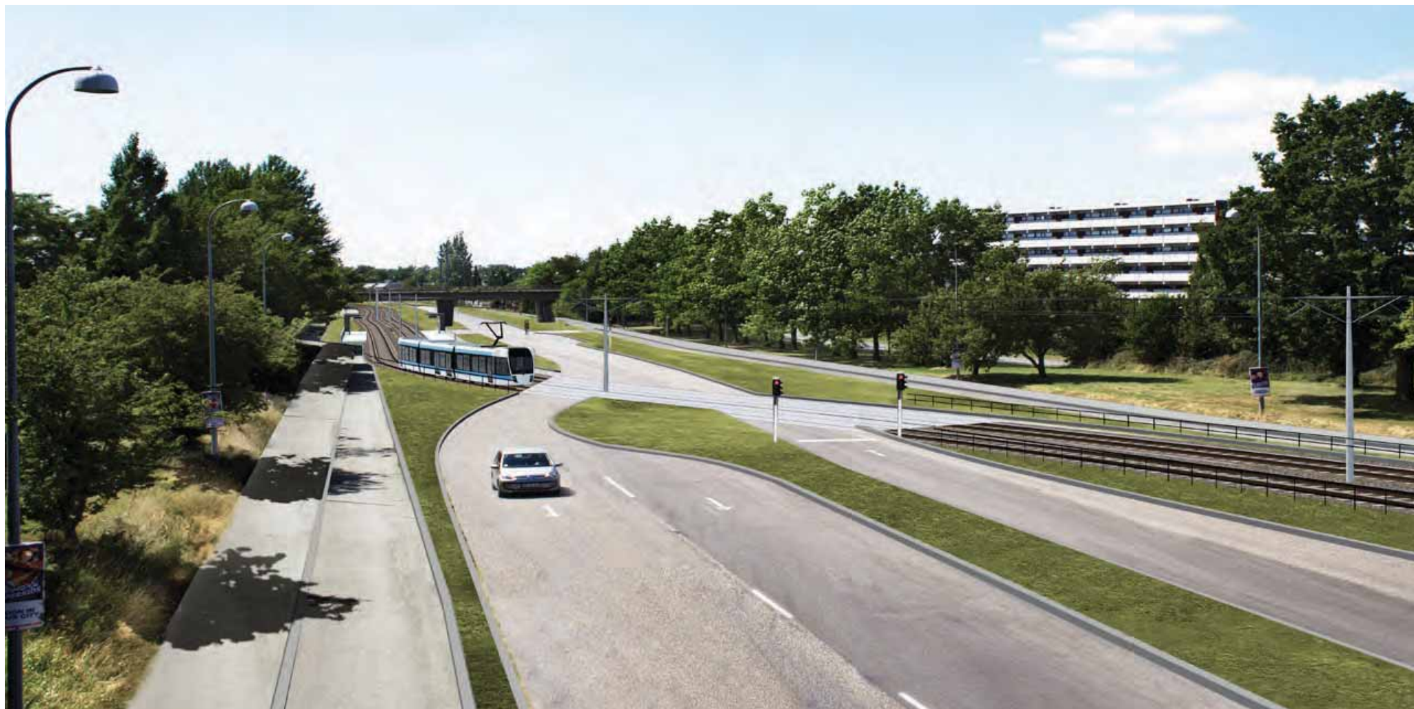
Station ved Vallensbæk S-station - sideperron
