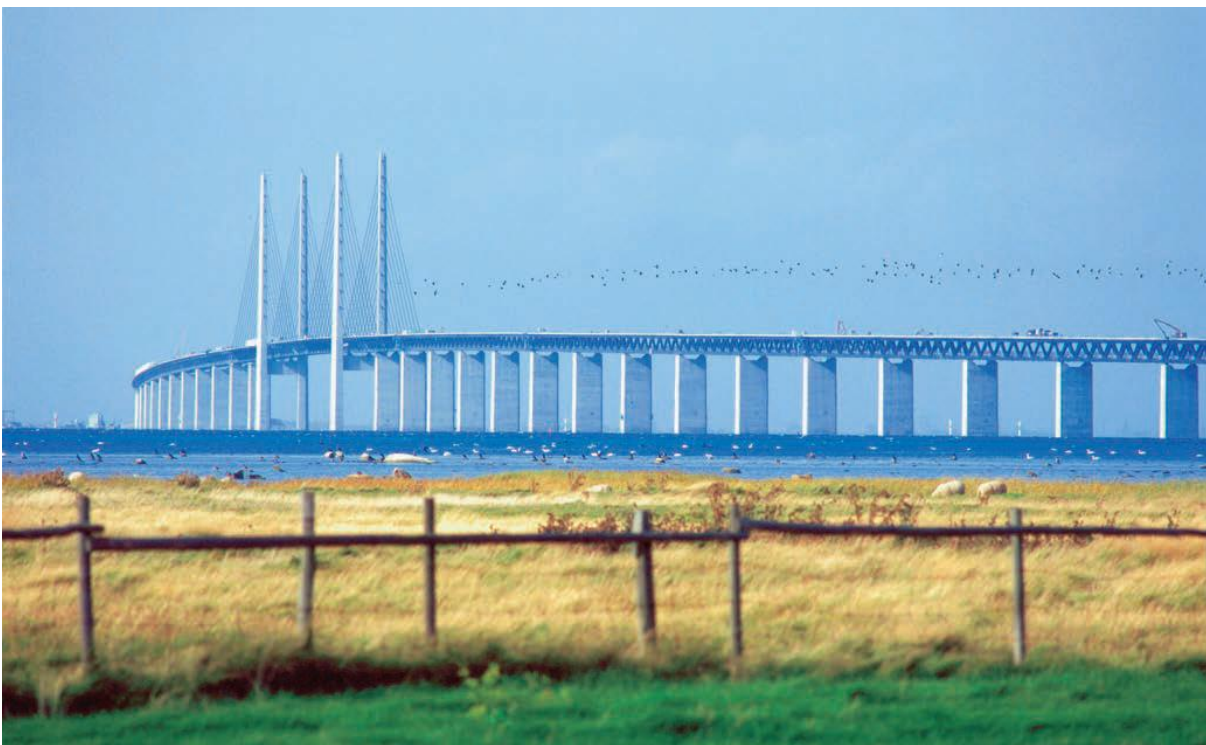
Figur 3.1 To etagers broforbindelse (Øresundsbroen).
