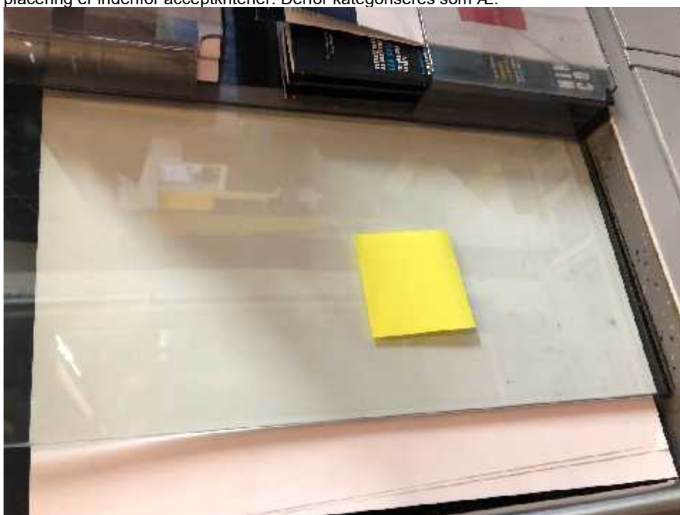
IMG2746: Indvendig rude, Omfang af ridser (<25% af ruden) samt ridsebredde og placering er indenfor acceptkriterier. Derfor kategoriseres som Æ.
